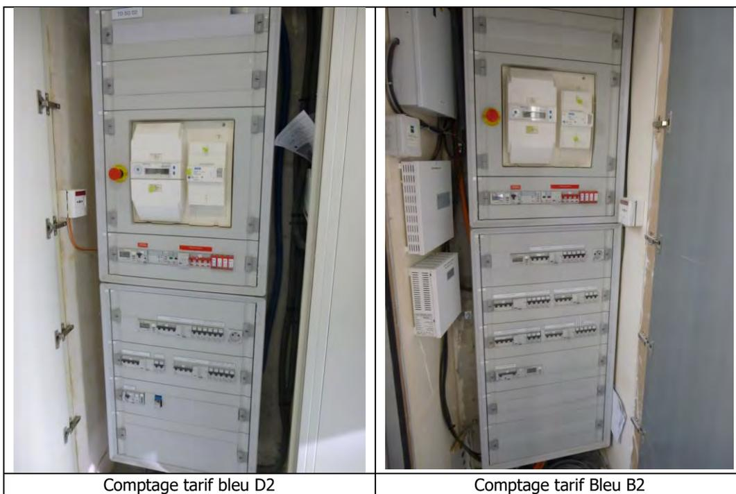
Le TGBT alimente les installations suivantes : Groupe frigorifique, éclairage des communs, pompe de relevage, sous station chauffage, divers vidéo, interphonie, sous station froid, etc.
